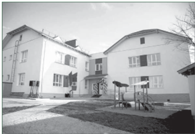
Grădinița nr. 140 „Ion Creangă” după renovare / ZdB
