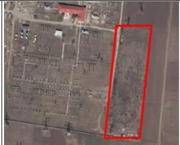
Fig. 2-3: Locația activității planificate pentru modernizarea SE Chișinău
