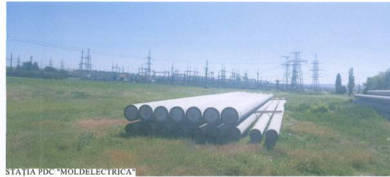
STAȚIA PDC "MOLDELECTRICA"
